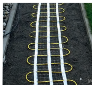
pokládka topné rohože HMO
