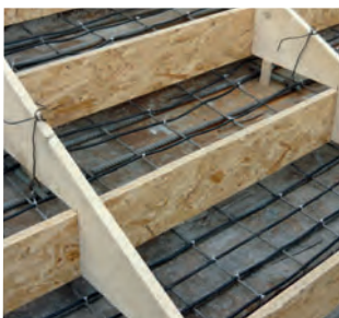
montáž topných kabelů TO-1T do venkovního schodiště
