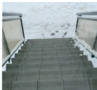
funkce topných kabelů ve venkovním schodišti
