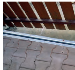
montáž SR-kabelu do pojezdové kolejnice vrat
